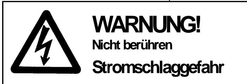
Abb. 4: Warnschild im Schaltschrank.
