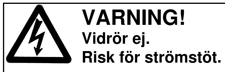
Figur 4: Varningsskylt i elskåp.
