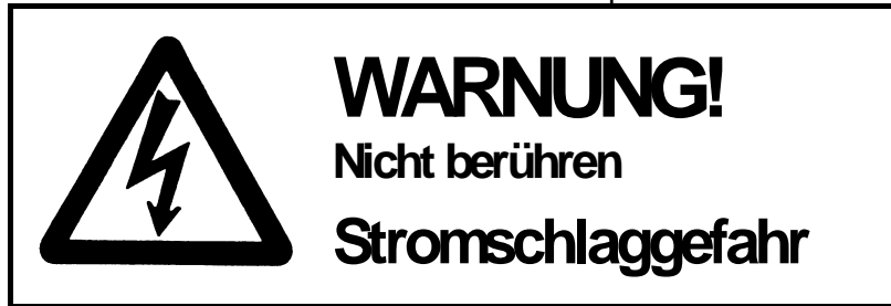
Abb. 4: Warnschild im Schaltschrank.
