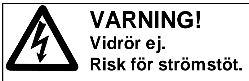
Figur 4: Varningsskylt i elskåp.
